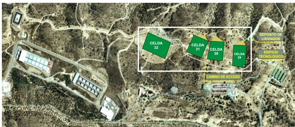
Figura 10. Vista aérea. Instalación de residuos de muy baja actividad (celdas 29 a 32).
