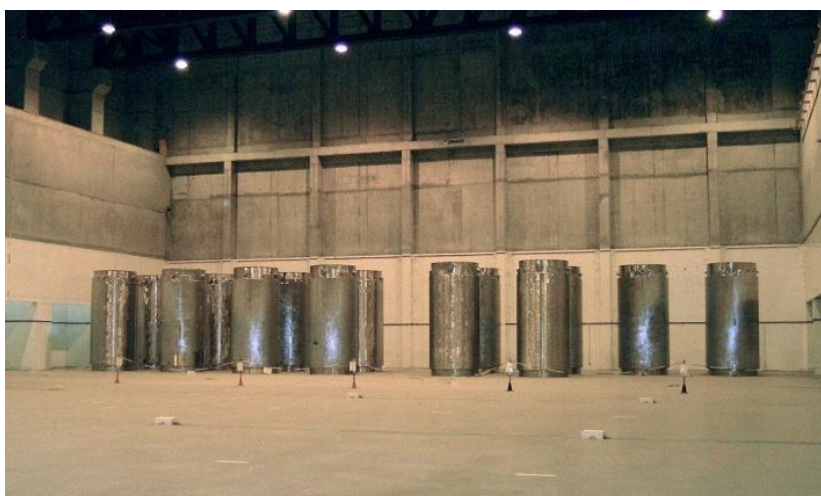
Figura 6. Vista del ATI de la Central Nuclear de Trillo.
